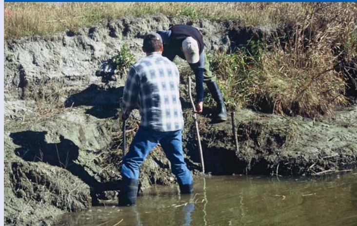
La rangée initiale de perches pour les barrières de fascines est placée à ras l'eau. Ces perches ont généralement un diamètre plus grand que celles placées horizontalement derrière cette rangée. Au moins 80 p. 100 des perches devraient être dans la terre comme cela est montré ici.
