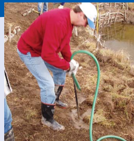
La rangée initiale de perches pour les barrières de fascines est placée à ras l'eau. Ces perches ont généralement un diamètre plus grand que celles placées horizontalement derrière cette rangée. Au moins 80 p. 100 des perches devraient être dans la terre comme cela est montré ici.
